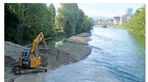
Limmat, Zürich Breitensteinstrasse Kiesschüttung (2'700m 3 ), 27.6.2011
