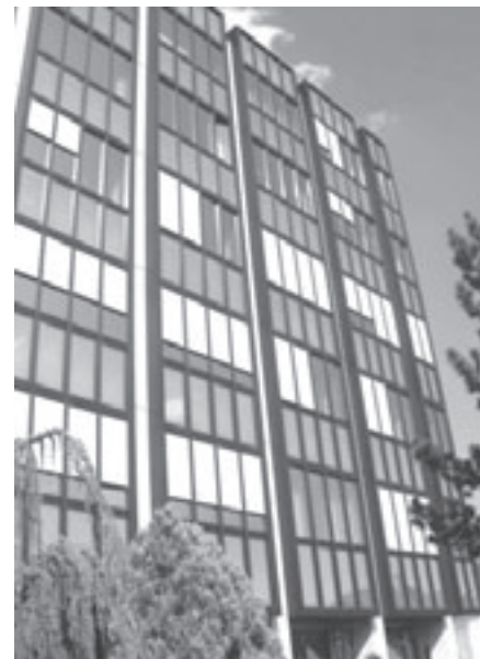
Auch im Gebäudebereich Elektrotechnik der ETH Zürich erfolgen Energieeinsparungen mit energho.
