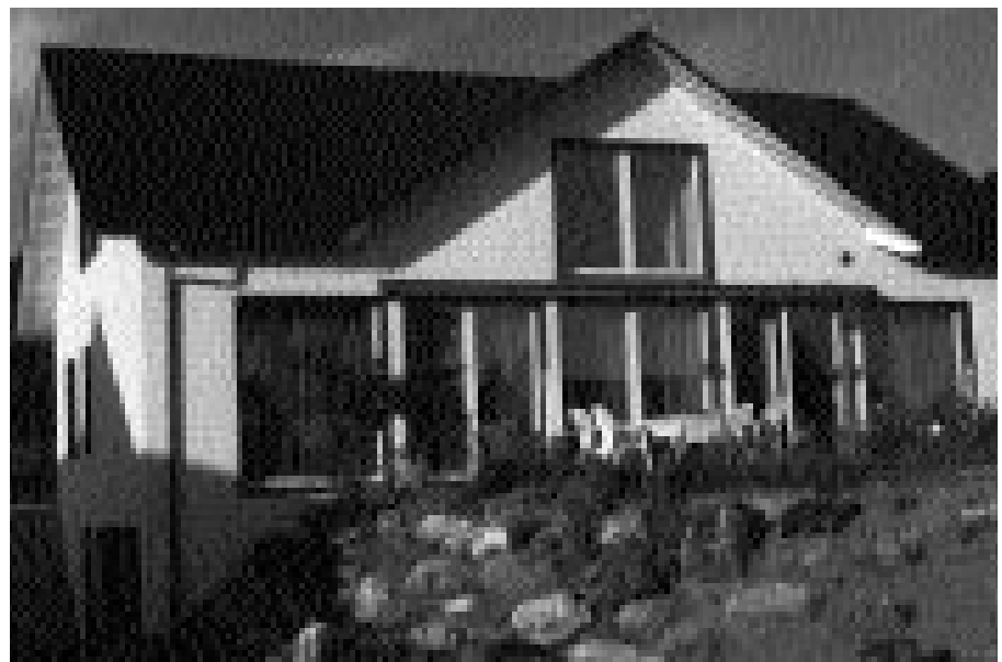
Durch Hochwärmedämmung erhöht Architekt Ruedi Fraefel den Wohnkomfort und senkt den Energieverbrauch deutlich.
