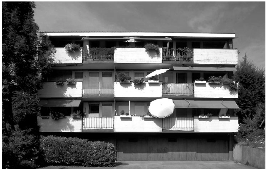
Ansicht des Mehrfamilienhauses vor der Sanierung...
