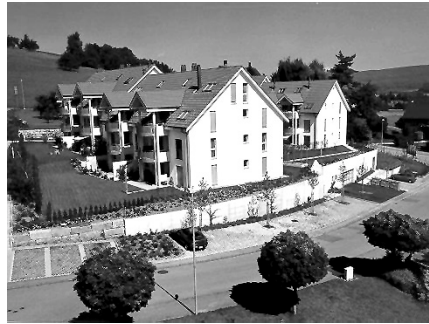
Ein Beispiel für Contracting: Die EKZ sind für den Unterhalt der Energiezentrale der vier Mehrfamilienhäuser in Lufingen verantwortlich.
