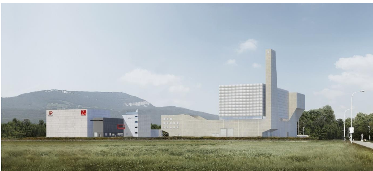
Abbildung 1: Visualisierung der neuen KVA KEBAG Enova und des möglichen Standortes SwissZinc mit Phos4life im Emmenspitz
